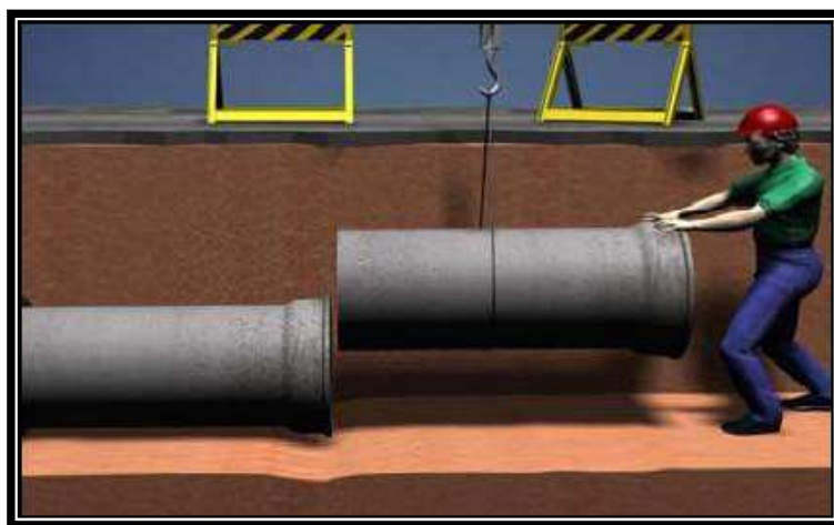
Figura 16 – Acoplamento de tubos de concreto
