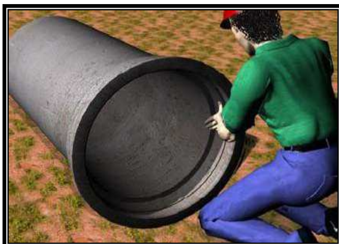
Figura 15 - Lubrificação do anel de borracha
