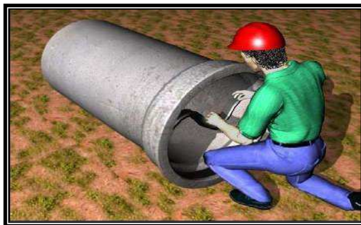
Figura 14 - Colocação do anel de borracha
